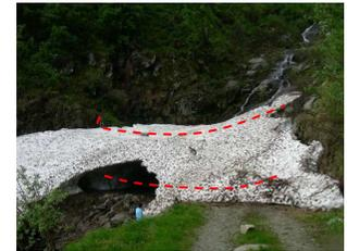
fig 11 - Vista della barriera post parziale scioglimento delle valanghe trattenute (foto del 05/06/14)
