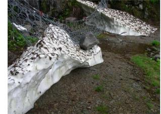
fig 12 - Vista della barriera post scioglimento delle valanghe trattenute (foto del 18/06/14)
