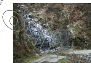
fig 10 - Vista della barriera installata lungo la zona di scorrimento della valanga Rio Colombari
